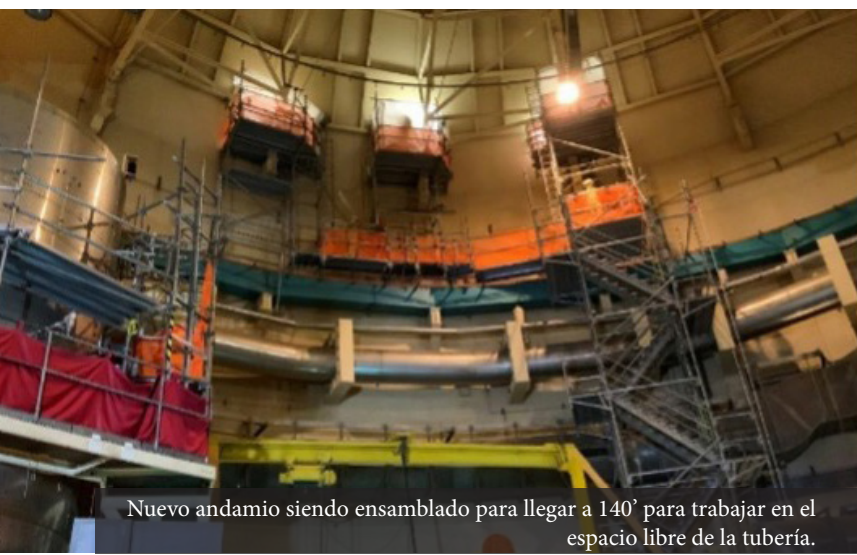
Andamios siendo instruidos cerca de la cúpula del reactor.
