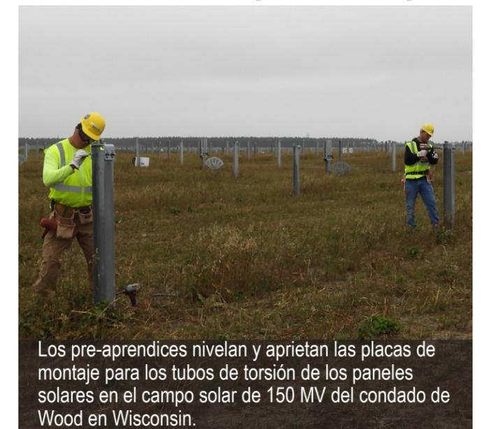
Los pre-aprendices nivelan y aprietan las placas de montaje para los tubos de torsión de los paneles solares en el campo solar de 150 MV del condado de Wood en Wisconsin.
